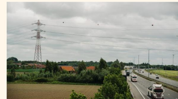
Om de vraag naar meer stroom op te vangen, heeft Elia nieuwe kabels nodig. @Wouter Van Vooren
