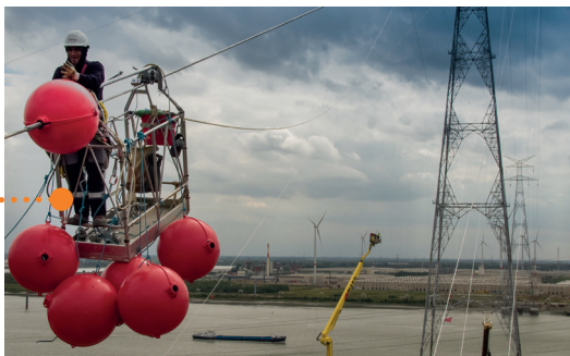
Des collaborateurs d'Elia installent des balises à l'aide d'un élévateur.
