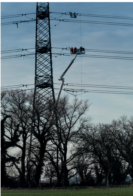
Des balises sont installées à l'aide d'une nacelle.
