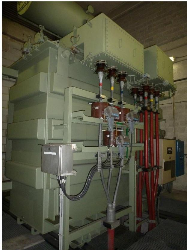
Figure 1.3 : câbles souterrains connectés sur un transformateur
