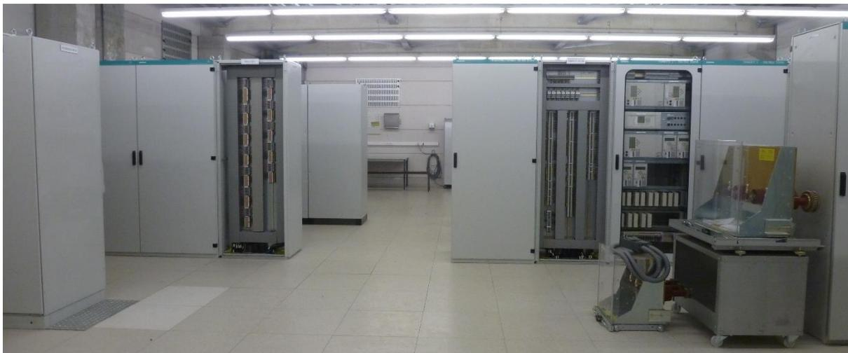
Figure 1.6 : équipements secondaires d'une sous-station
