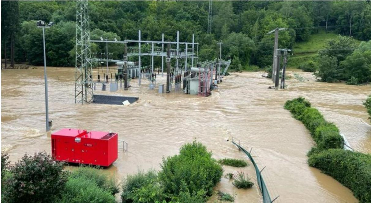
Figure 2.8 : Inondation d'un poste à haute tension suite aux pluies extrêmes de juillet 2021
