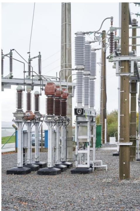
Figure 2.6 : Premier disjoncteur sans SF6 d'une nouvelle génération sur le réseau 70kV d'Elia (sous-station 70kV de Marcourt)
