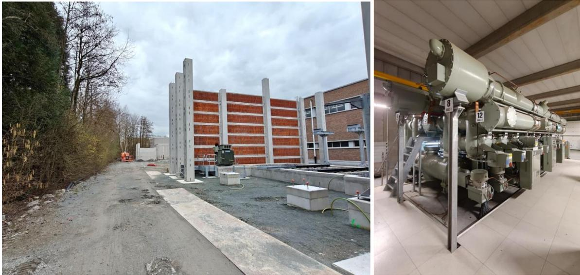
Figure 1.5 : sous-station 150 kV de type GIS
