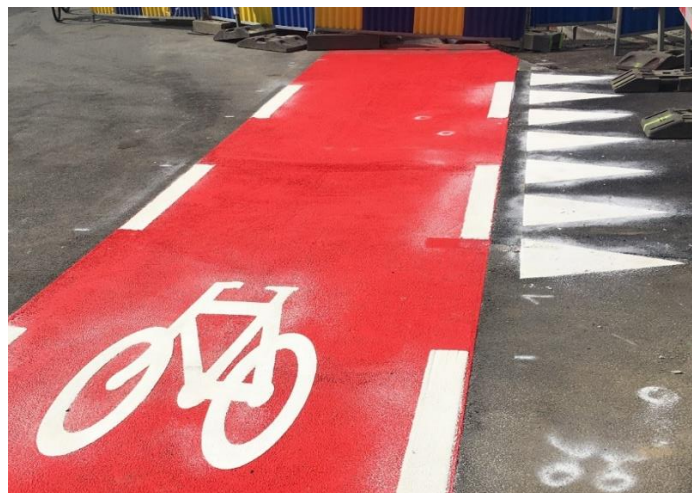
Figuur 1.9 : Fietspad hersteld na kabelwerken
