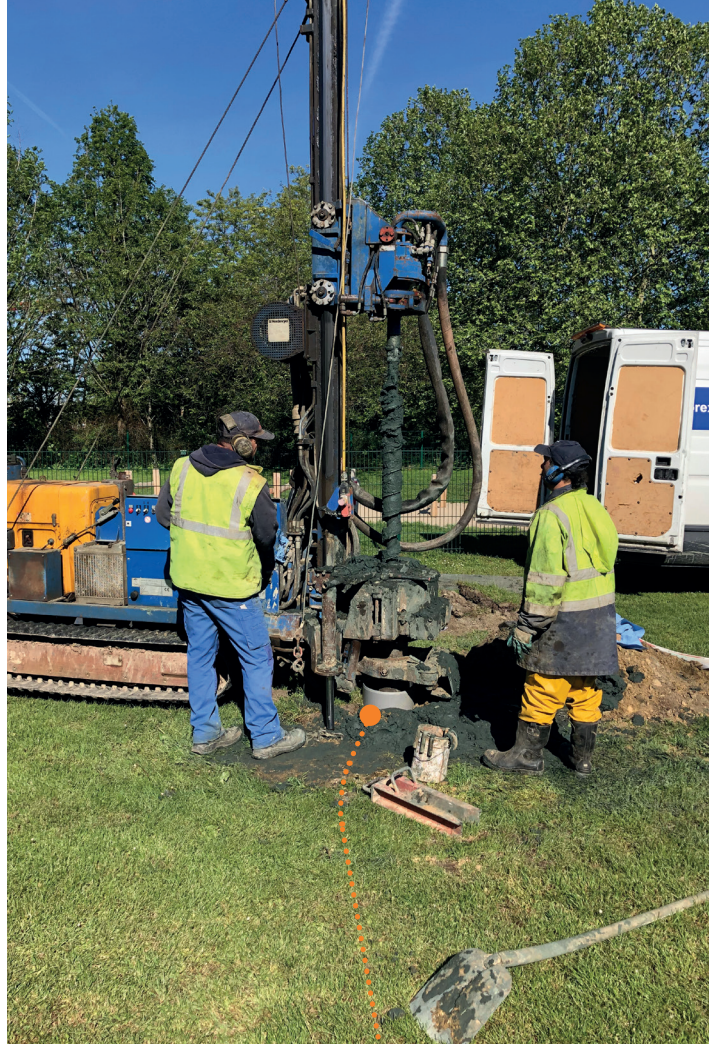
Un sous-traitant procède à un forage de sol.
