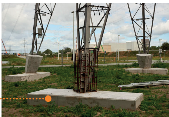
Fondation renforcée d'un pylône existant.
