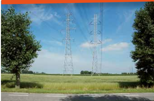
Links: Bestaande 150 kV-lijn met klassieke mastarm Rechts: Toekomstige 380 kV-lijn met geïsoleerde mastarm
