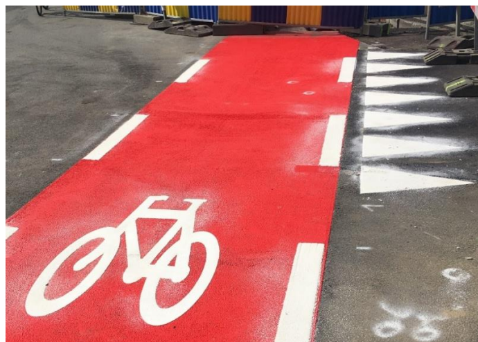
Figuur 1.9: Fietspad hersteld na kabelwerken
