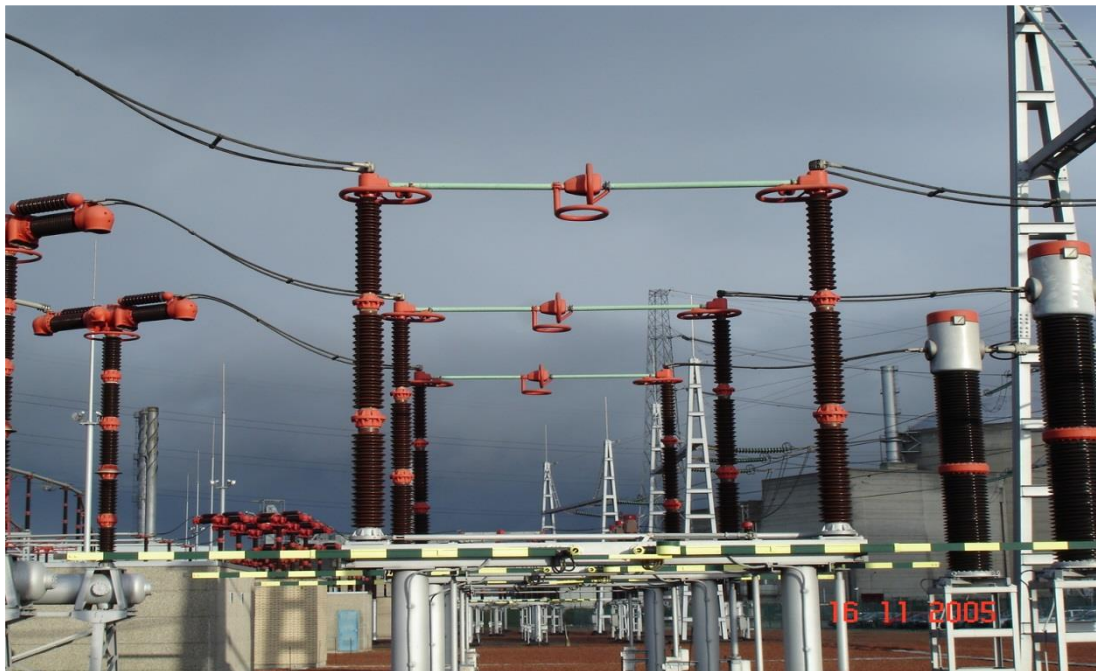
Foto 5: Lijnscheiders, type horizontaal rotatief (in gesloten toestand)
