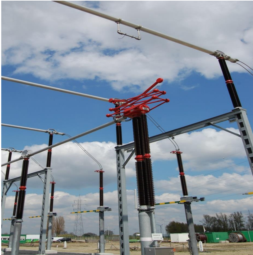
Foto 4: Railsscheider, type pantograaf met aarders (groen-geel) op de achtergrond.
