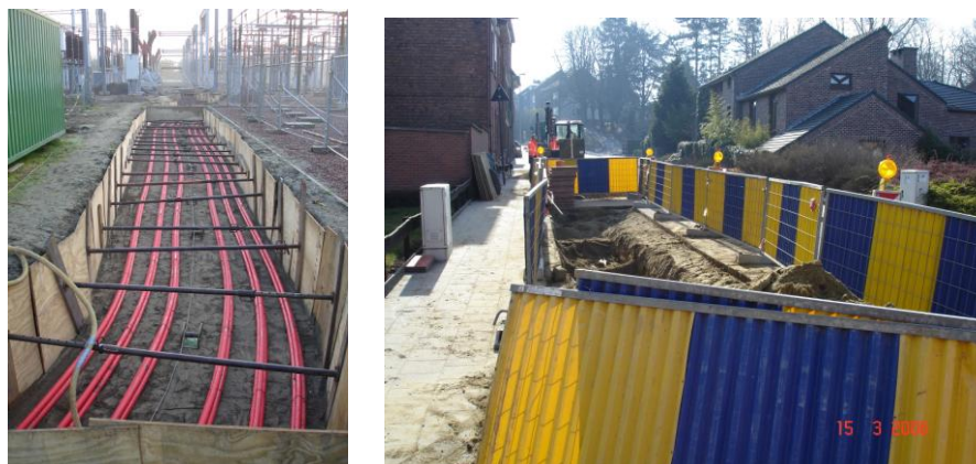
Figure 36 : Foto tranchée de câble
