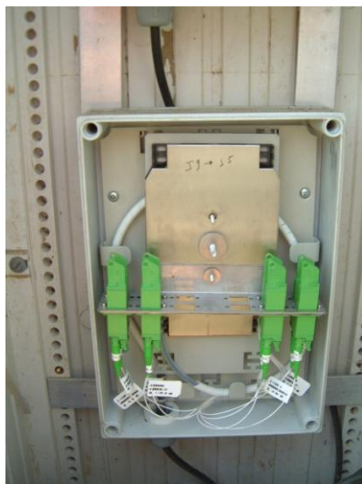
Figure 18 : Câble à fibres optiques (FO) prêt pour une mesure de température
