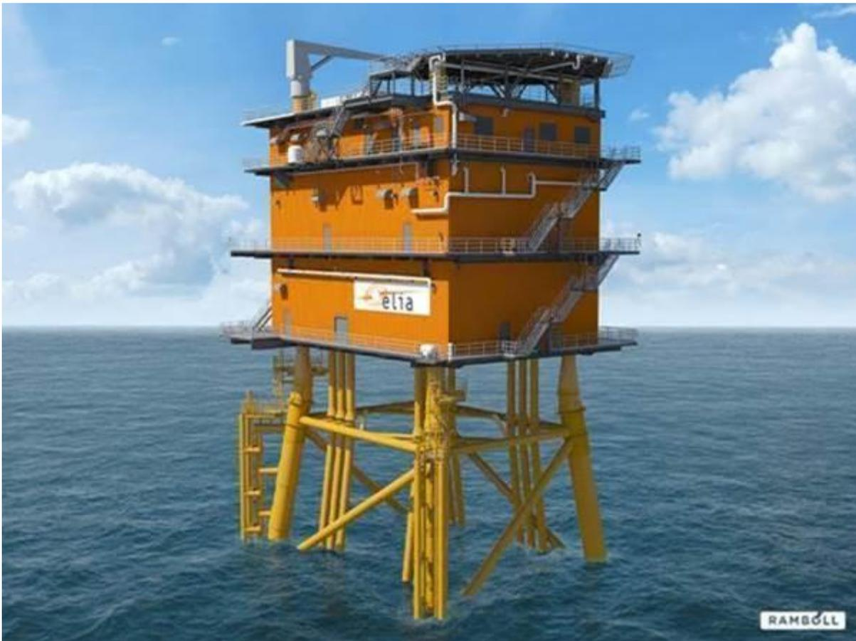
*Le Modular Offshore Grid se compose deux parties clés : la jacket, ancrée au fond de la mer à une profondeur de 60 m à l'aide de 4 pieux. Au-dessus de celle-ci, on posera le topside. Celui-ci se compose d'une salle des câbles où ils arrivent et repartent, d'une salle de commutation et d'une salle de contrôle.*
