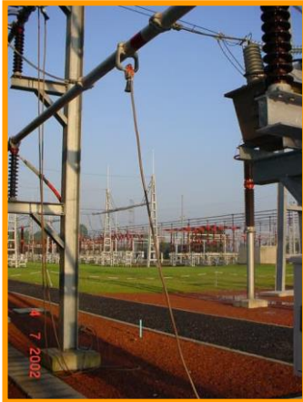
Mise à la terre volante résistante au court-circuit
