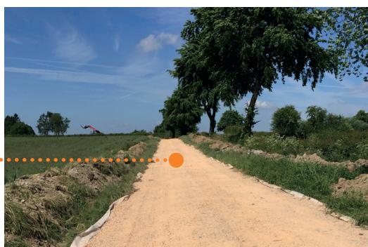
Een toegangsweg in steenslag.
