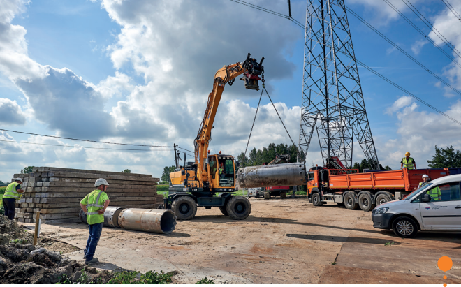
Levering van materiaal aan het werkplatform rondom de mast.
