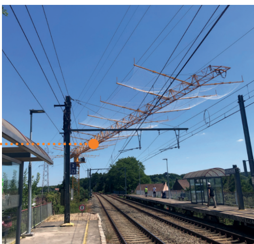
Een kraan met beschermnet beschermt de spoorlijnen.
