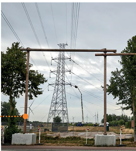
Installatie van twee houten portieken onder een luchtlijn.
