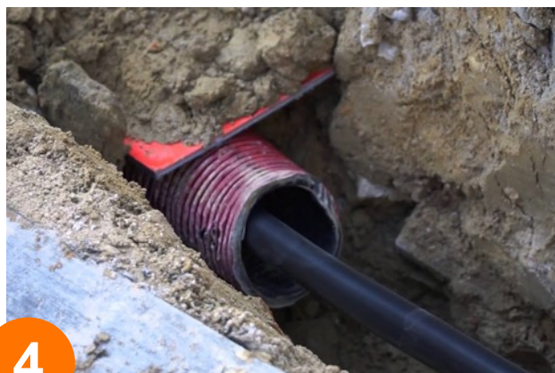
Kabels door wachtbuizen
