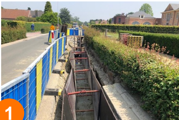
Graven open sleuf + kabeltrek
