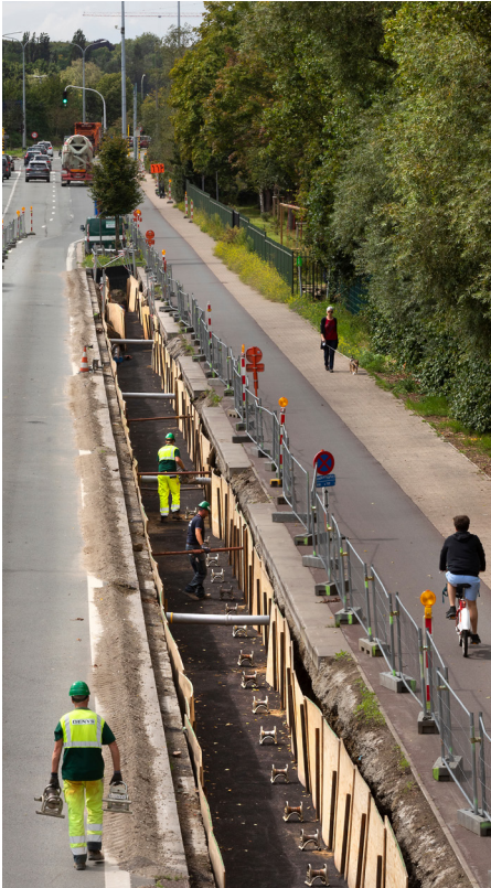
Aanleg ondergrondse kabelverbindingen
