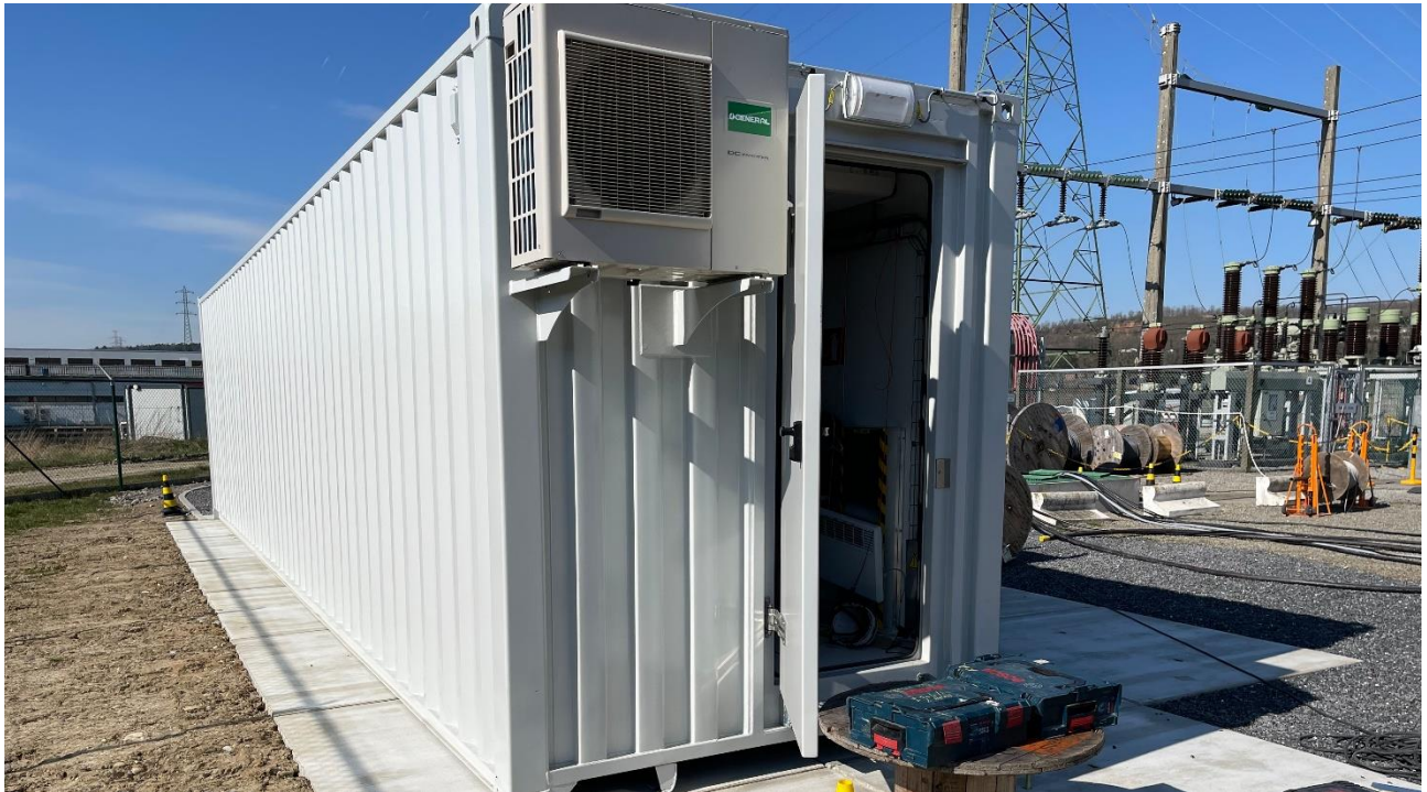
Salle à relais provisoire pour permettre la construction d'une échelle à poissons à Ampsin
